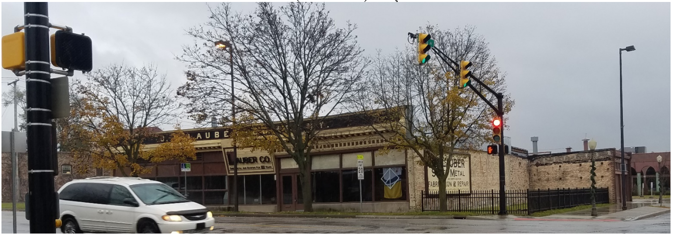
NORTH (LASALLE) FAÇADE
