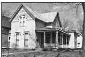
425 Lamont Terrace Gabled-Ell
