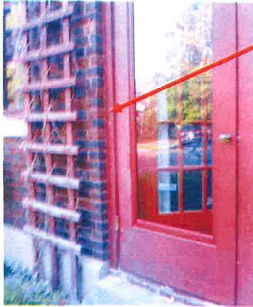
HOUSE - DOOR FRAME, SIDE A
