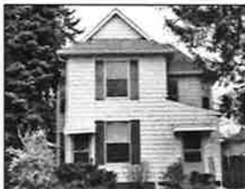
738 Leland Avenue Gabled-Ell
