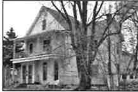
711 Leland Avenue Gabled-Ell
