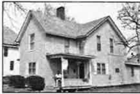
728 Leland Avenue Gabled-Ell
