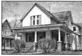
419 Lamont Terrace Gabled-Ell
