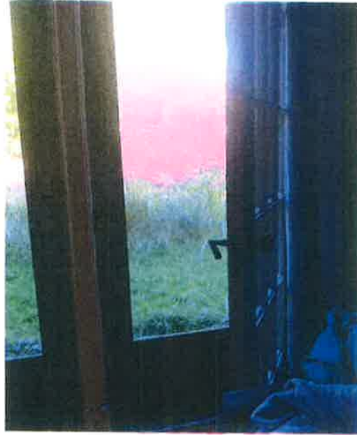
LIVING ROOM - DOOR JAMB, SIDE D
