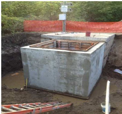
NEW CSO 018 STRUCTURE
