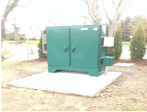
CSO 025 CABINET REPLACEMENT
