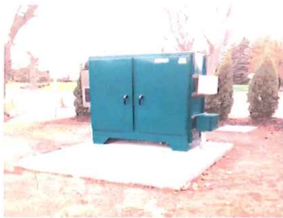
CSO 025 CABINET REPLACEMENT
